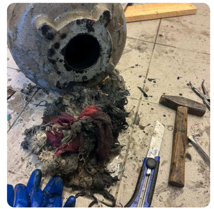
Abfälle und Stoffteile, die die Pumpe blockiert haben.
