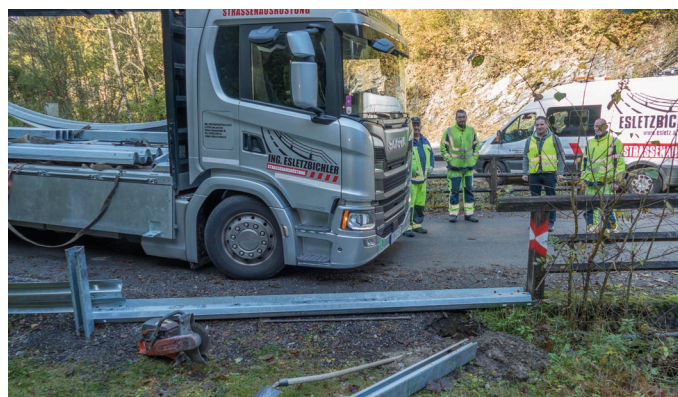
Sicherung der Güterwege - Leitschienenmontage im Obertal und Thoreben.
