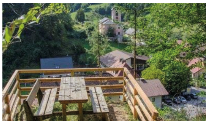
Das „Schwarzenbacher Aussichtsplatzl“ wurde mit einem Geländer versehen.
