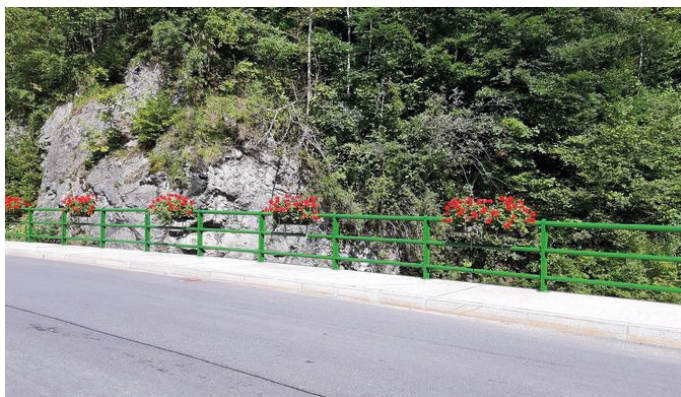
Instandsetzung der Geländer bei den Brücken und beim FF-Haus.
