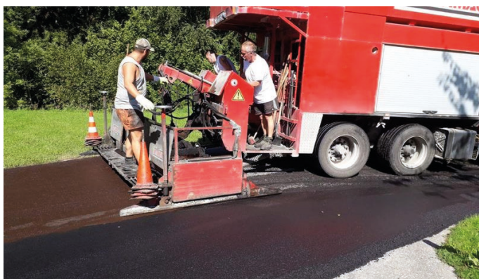
Oberflächenversiegelung der Güterwege Stuppach und Unterwindhag.
